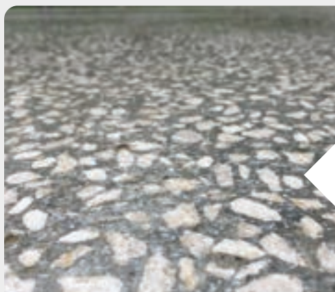
PONÇAGE AVEC BOUCHARDAGE
