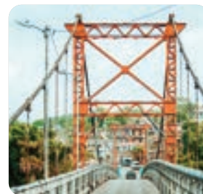
PONTS ET TABLIERS EN ACIER
